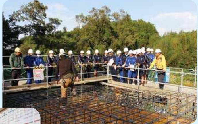
施工中のカルバート工、橋台工を見学しました。
