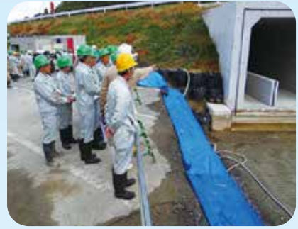
現場打ボックスカルバート工を見学
