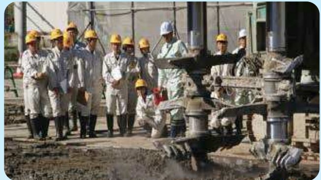
地盤改良スラリー攪拌(CMC工法)
