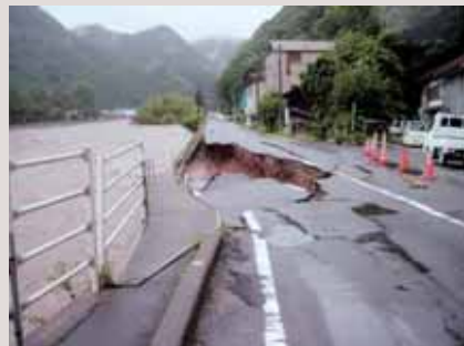
国道184号 八幡原橋付近
