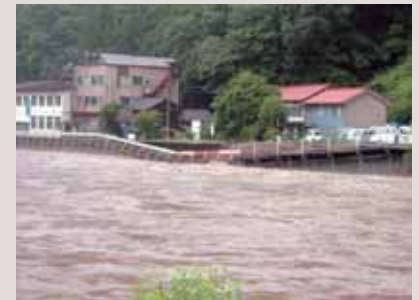
国道184号 八幡原橋付近
