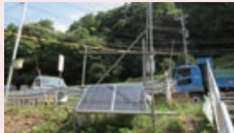
現場内太陽光パネル設置
