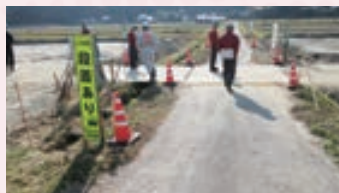
安全対策（段差注意）の確認
