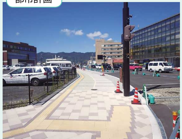
出雲市駅前矢尾線(3工区) 防災安全交付金(街路) 事業 電線共同溝工事 (株式会社中筋組)
