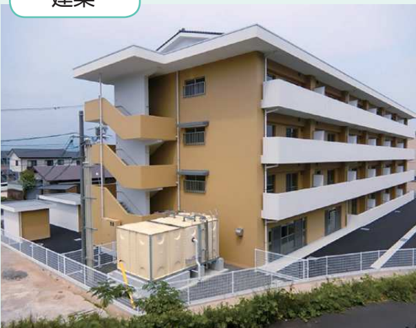
島根県営住宅(出雲市牧戸団地1号棟) 建設(建築) 工事 (山本工務店・昭和開発工業特別共同企業体)
