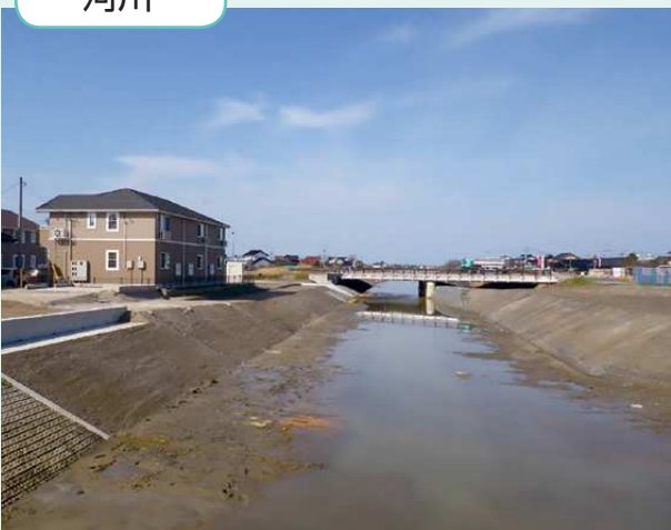
赤川 県単河川緊急整備工事 掘削工(第1期) (株式会社トガノ建設)
