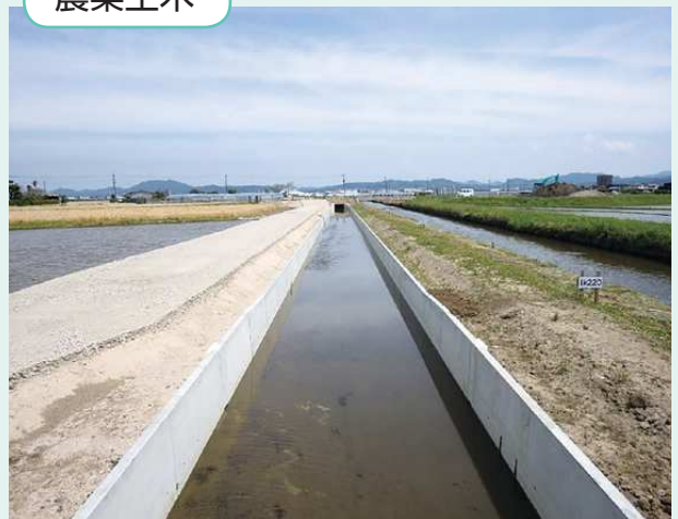
平成27年度 水利施設整備事業(排水対策特別型) 入南南地区 排水路(その5) 工事 (株式会社中筋組)
