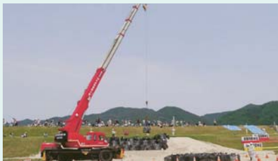
大型土のう工の実施状況
