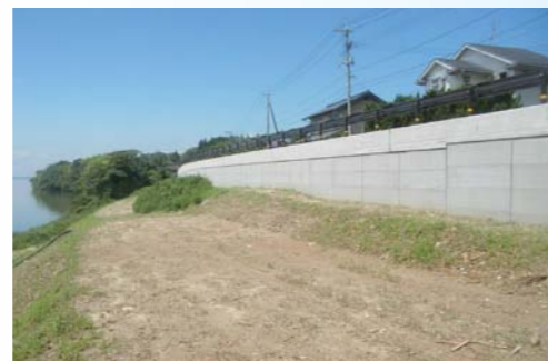
国道431号美野工区 地域活力基盤創造交付金(交通安全)工事
