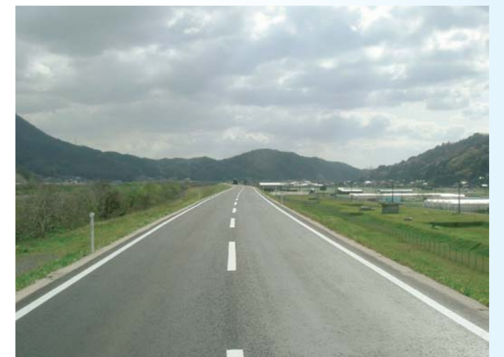
(主)出雲三刀屋線船津工区 舗装整備工事
