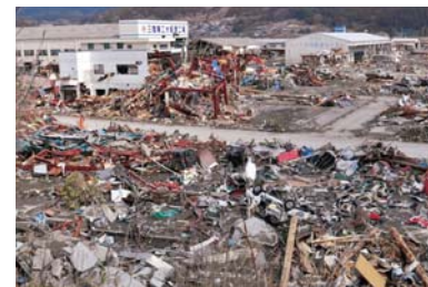
被災した大船渡市中港地区
