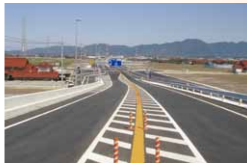
(一)出雲インター線 知井宮工区 改築(改良)工事 第4期
