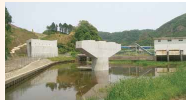
平成20年度(主)出雲三刀屋線 船津工区 地方道路交付金(交通安全)工事 第2期工事
