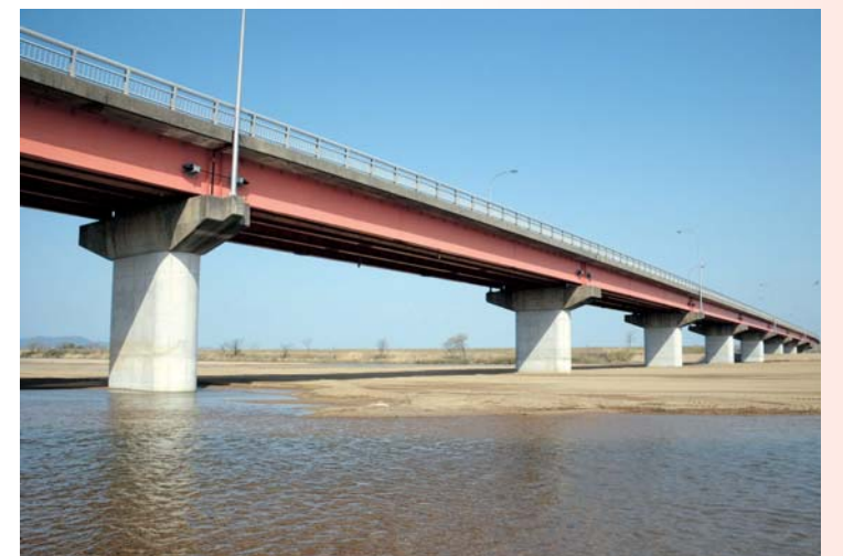
斐川出雲大社線（北神立橋）地方道路交付金（橋梁補修）工事
