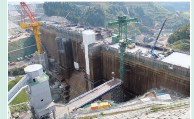
展望台から見たダム本体工事
