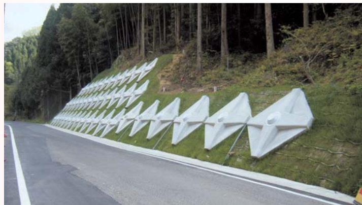
平成20年度 ふるさと農道整備事業朝山地区法面工事
