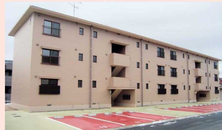
中央病院小山医師共同宿舎改修(建築)工事
