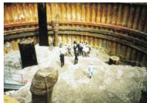
ドーム型展示棟の工事現場。右側にあるのが第一発見の杉の木。
